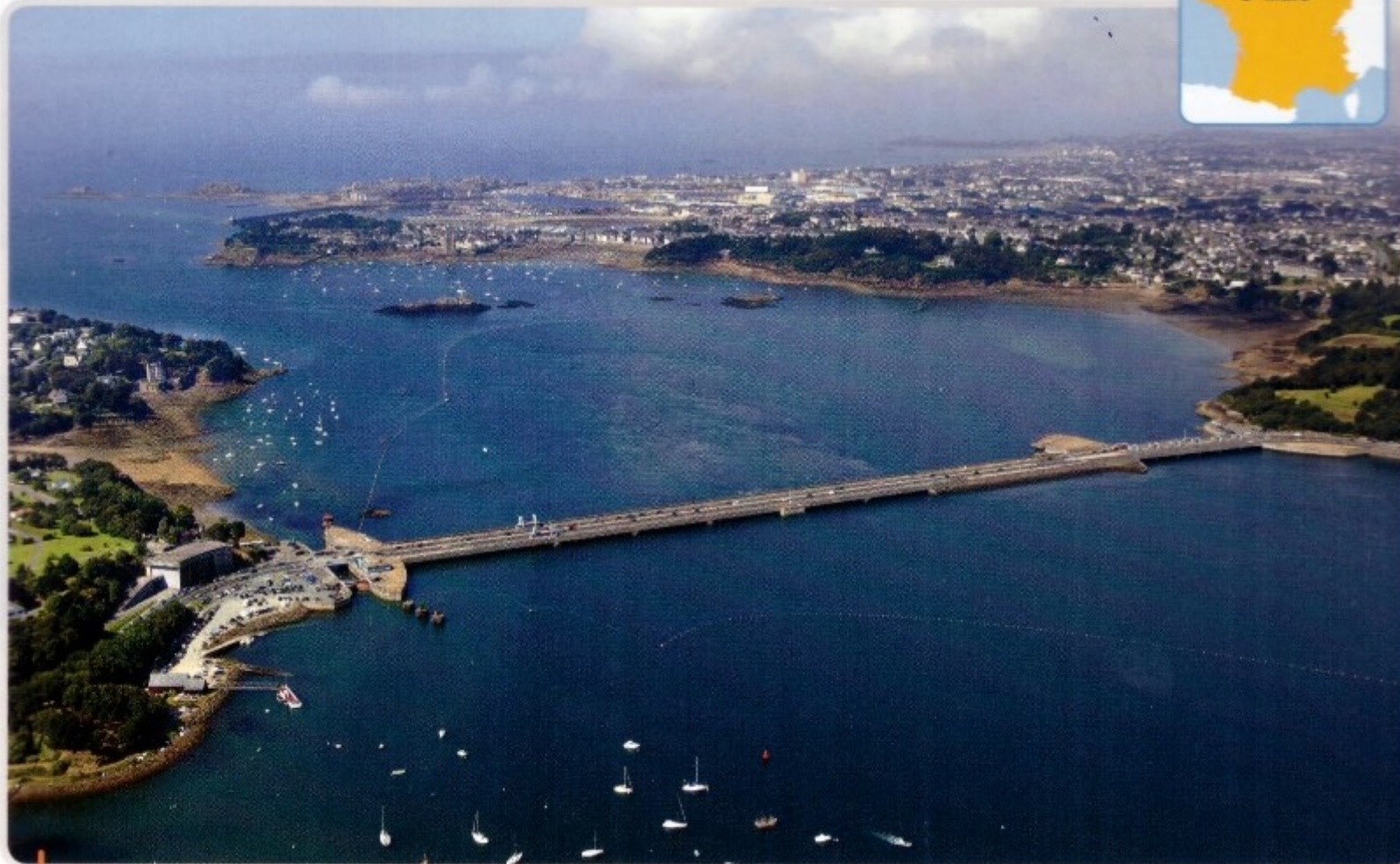
Centrale marémotrice de la Rance.
